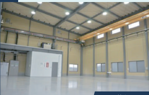
28t天井クレーン
